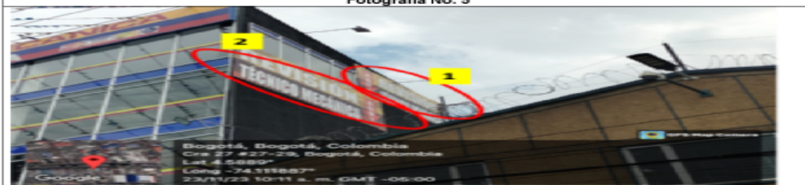
En la cual se observa: dos (2) elementos PEV ubicados al costado izquierdo de la edificación identificados con los números 1 y 2, el elemento 1 esta ubicado en las ventanas y el elemento 2 alcanza a cubrir parte de estas.
